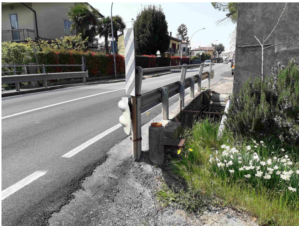
Foto 11 – Attraversamento C (Rio Rul, intersezione con Via IV Novembre), vista del paramento lato monte. Il nuovo attraversamento aereo di acquedotto affiancherà il ponte, passando fra il ponte stesso e la cabina elettrica (dismessa)
