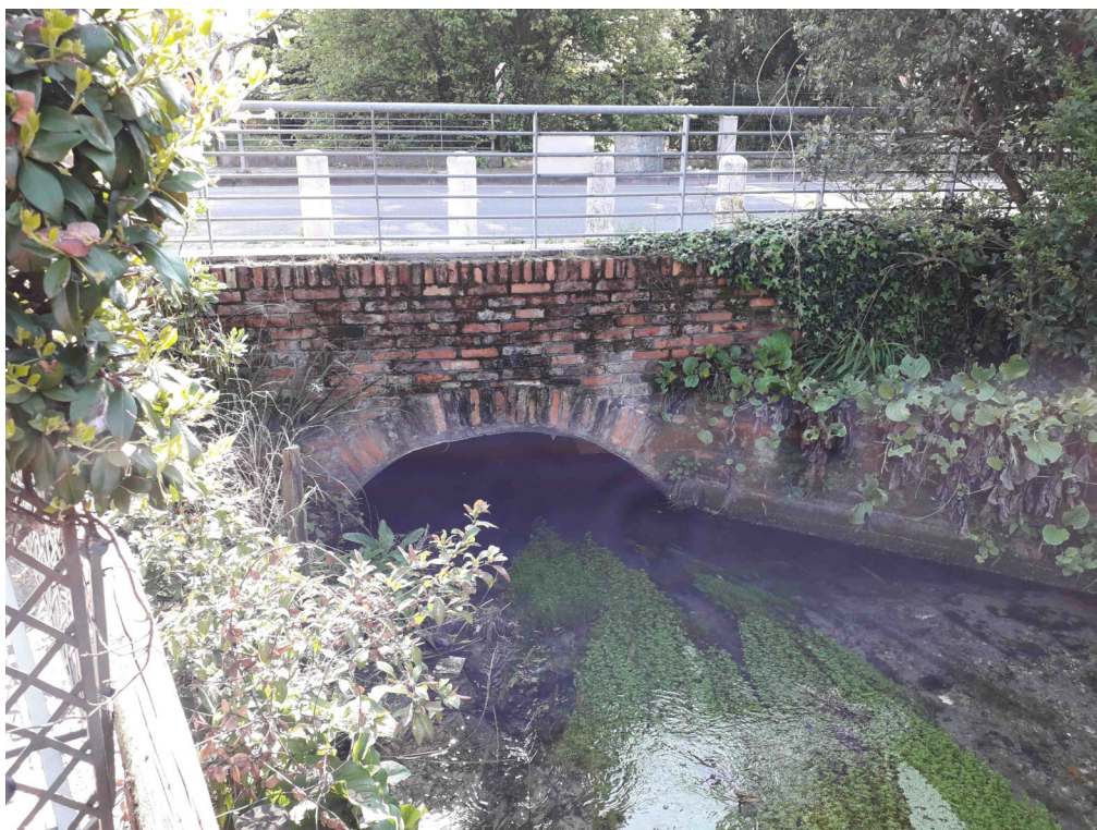
Foto 7 – Attraversamento B (Rio Piovensan nord, intersezione con V.le Vittorio V.to), vista del paramento lato monte. Il nuovo attraversamento di acquedotto viene realizzato in spessore di ponte. Risulterà visibile il solo sfiato, posizionato sul lato monte, protetto da un carter in acciaio
