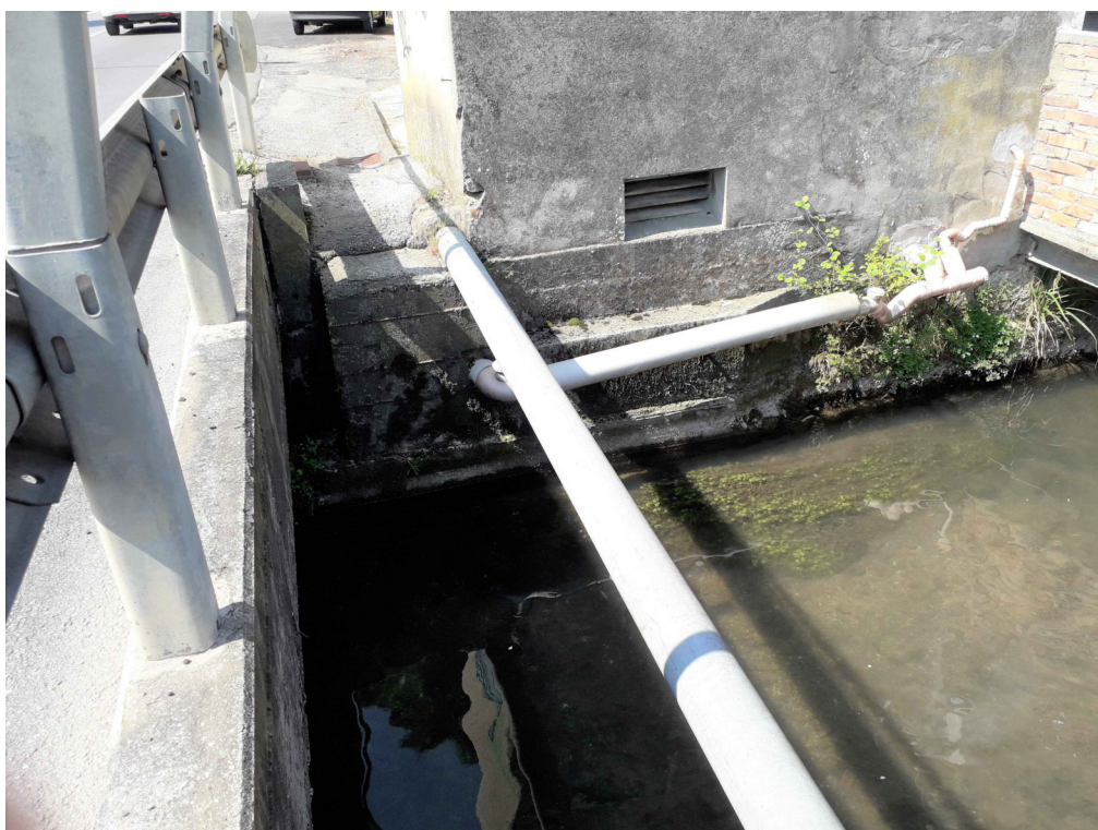
Foto 12 – Attraversamento C (Rio Rul, intersezione con Via IV Novembre), vista del paramento lato monte. Il nuovo attraversamento aereo di acquedotto affiancherà il ponte, passando fra il ponte stesso e la cabina elettrica (dismessa)
